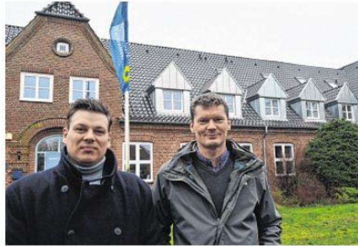
Hat alles gut geklappt: Kreis-Liegenschaftsverwalter Brar Hassold und der Leiter der Nordsee-Akademie, Aaron Jessen (l.) vor dem mit neuen Gauben ausgestatteten Gebäude. FOTOS: ARNDT PRENZEL
